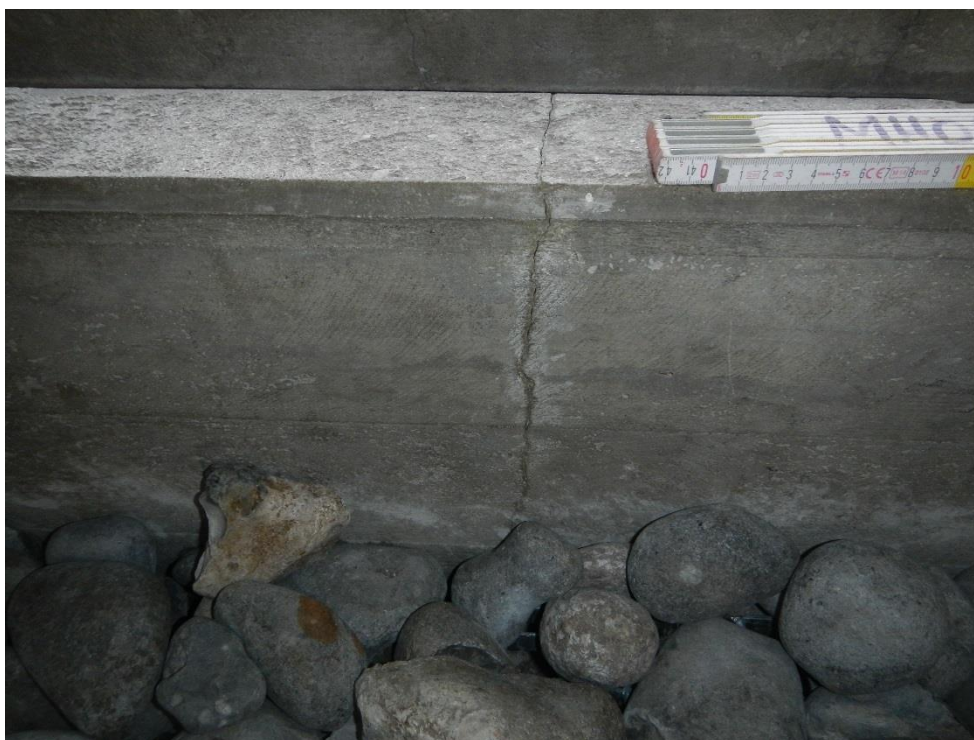
Foto 7.1.3 – Revne i kantbjælke. Revnevidde ses at være størst i overside af bjælke.
