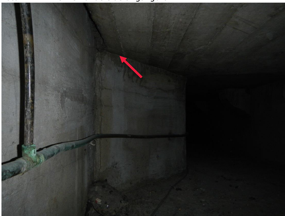
Foto 7.1.8 – Understøtning for kantbjælke i dækkonstruktion.
